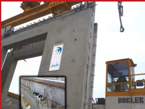
Vorgefertigte Betonelemente mit Rohbauset Prefabricated concrete elements with ventilation system shell
