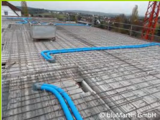
Verlegen der Abluftleitungen auf der Filigrandecke
