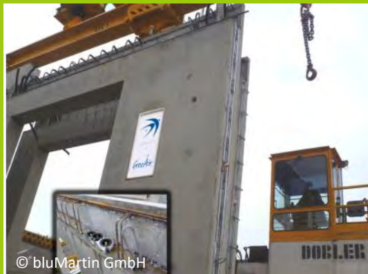
Vorgefertigte Betonelemente mit Rohbauset inklusive abgedichteter Zweitraumanschlüsse Prefabricated concrete elements with ventilation system shell including sealed connections
