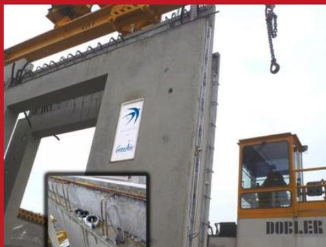
Vorgefertigte Betonelemente mit Rohbauset
