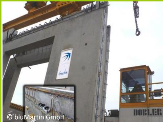
Vorgefertigte Betonelemente mit Rohbauset inklusive abgedichteter Zweitraumanschlüsse
