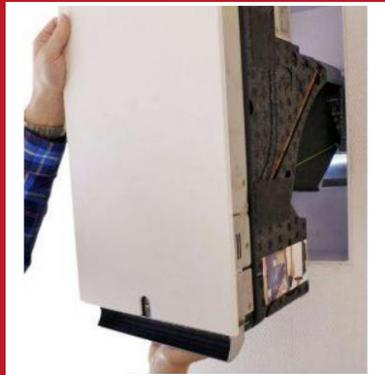
Fassadenintegriertes Lüftungsgerät free Air 100
