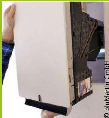
Einsetzen des freeAir Gerätes in den Mauerereinsatz
